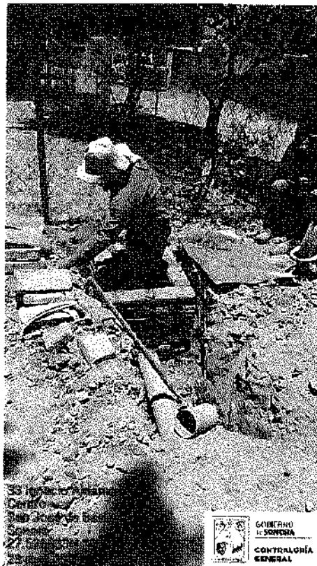
Construcción de pozos de visita y registros sanitarios en la Localidad de El Juvani
