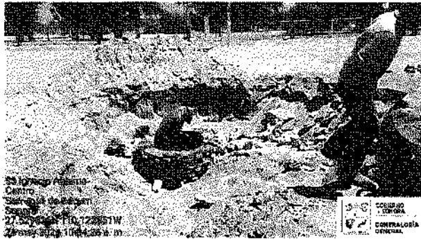
Construcción de pozos de visita y trazo y excavación de pozos para su construcción en la Localidad de El Juvani
