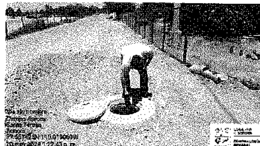
Construcción de pozos de visita, colocación de brocales y profundidades de pozos de visita en la Localidad de Santa Teresa.
